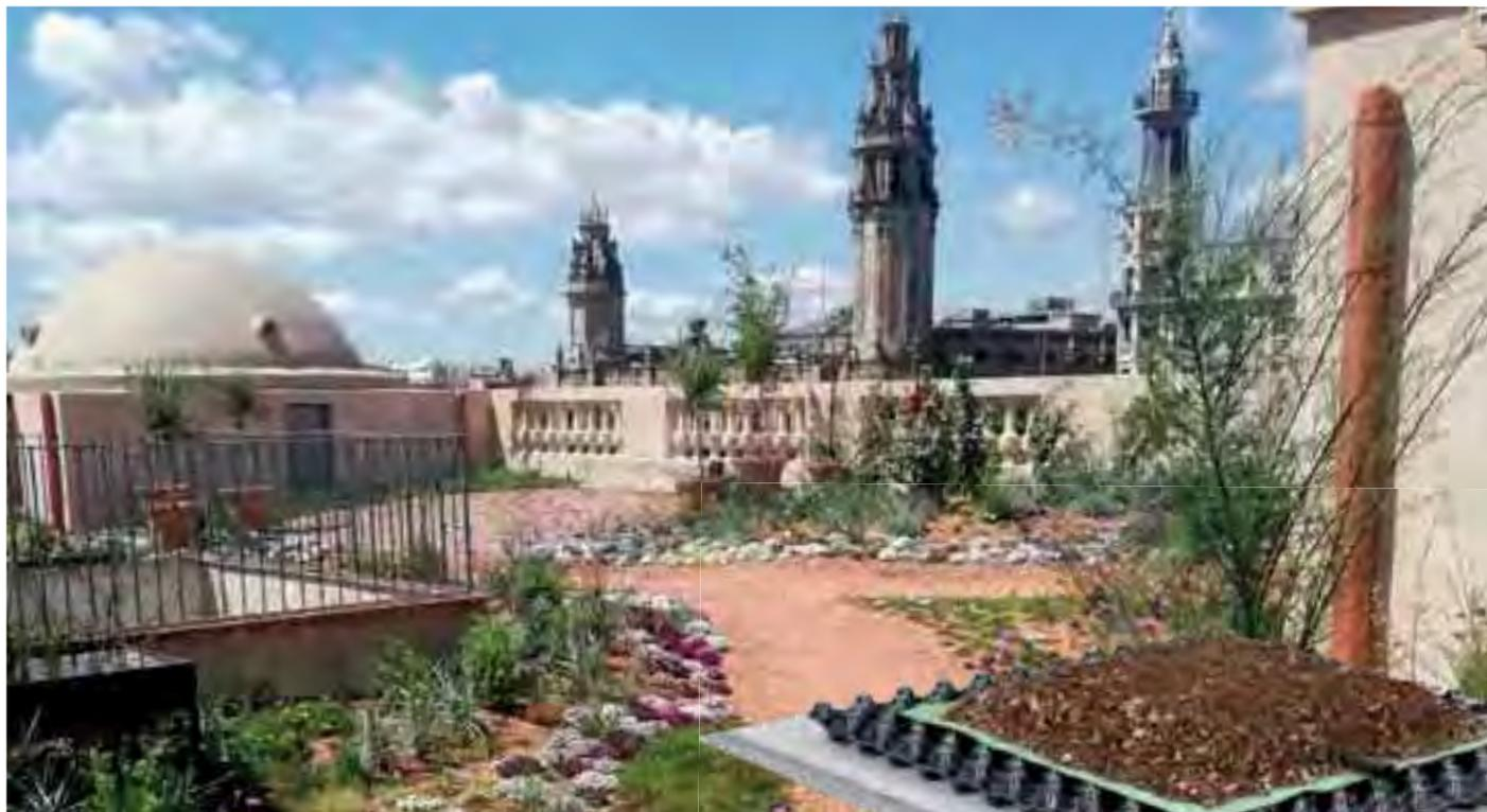
A diferencia de un sistema de riego convencional, como un sistema por goteo, este sistema de cubierta verde utiliza un sistema de riego por capilaridad que reduce considerablemente el consumo de agua poniéndola directamente a disposición de la raíz de la vegetación y sin pérdidas por evaporación en superficie. Además se requieren menor número de tuberías de riego y menor número de goteros en dichas tuberías. Esto implica también un significativo ahorro económico en la instalación.
