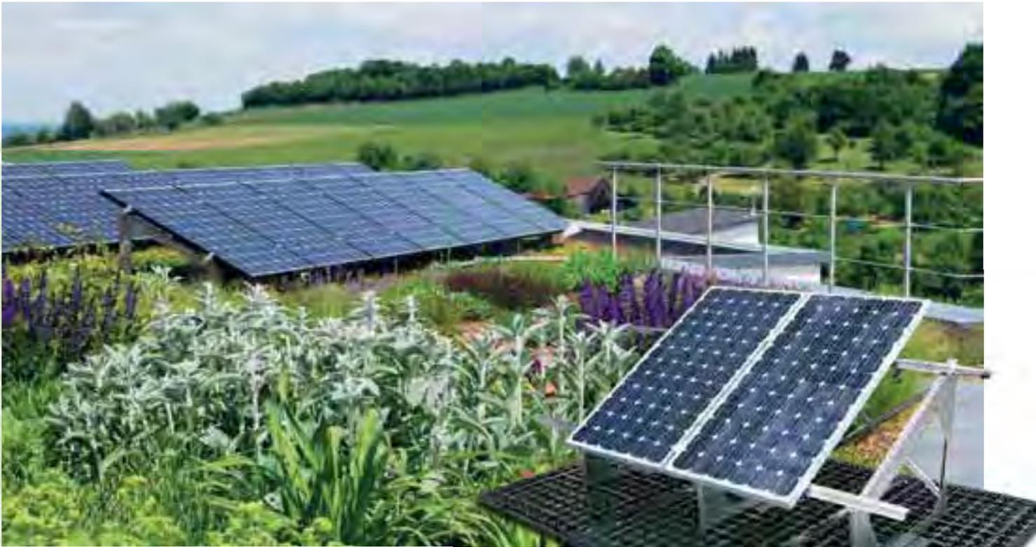
ZinCo aumenta las ventajas de la tecnología de las cubiertas verdes con el desarrollo de bases de soporte para los paneles solares. Con la innovadora Base Solar, la energía solar se puede integrar en los sistemas de cubiertas verdes sin perforación de la impermeabilización, ya que el sistema de cubierta vegetal proporciona la carga necesaria para mantener la estructura estable. Pero lo que más importa es que el sistema SolarVert favorece las sinergias entre ambos
