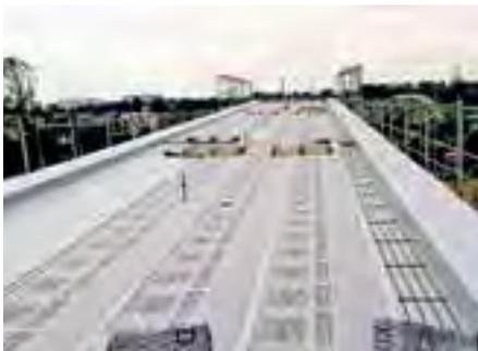
El sistema de cubierta verde con el elemento de drenaje Fixodrain® XD 20 es la base sobre la que se sienta la cubierta biodiversa.
