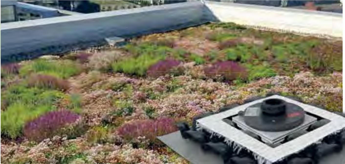
El sistema "Sponge City Roof" permite la gestión semi-natural del agua de lluvia. El diseño del sistema combina, por un lado, las ventajas de una cubierta extensiva rica y diversa en especies vegetales, más una reserva adicional de agua para el consumo de las plantas, y una retención temporal de pluviales con escorrentía progresiva regulada.
