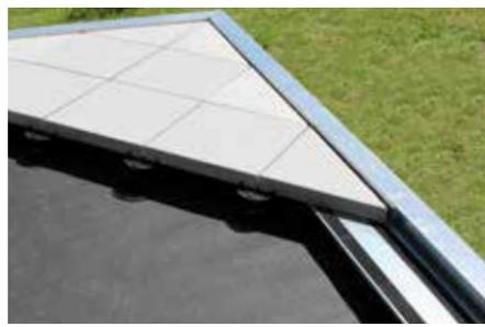
Por ejemplo, cuando los bordes de una zona pavimentada no son ortogonales respecto al patrón de colocación de las losas, se utiliza el soporte a inglete para bordes, brindando un apoyo seguro.
