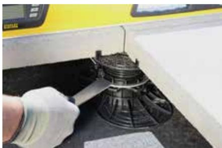
La nueva herramienta de ajuste permite una fácil regulación y un ajuste preciso de la altura requerida, incluso después de la instalación de las losas.
