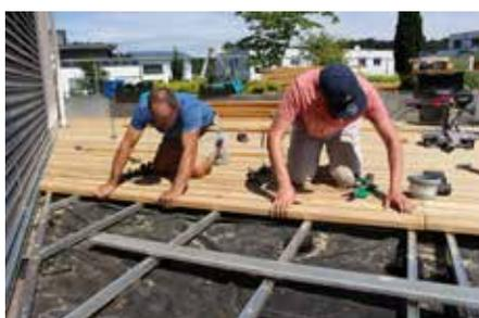
Las tarimas de madera se pueden fijar fácil y rápidamente al sistema de rieles sin apenas esfuerzo.
