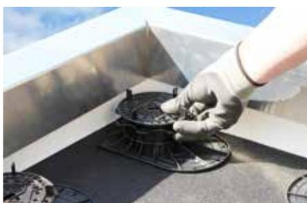
La forma ovalada de la nueva placa base Elefeet®, permite colocar el soporte elevador hasta el borde de la cubierta. Con un corte de la placa base por la línea marcada se consigue un posicionamiento aún más preciso del soporte en las esquinas.
