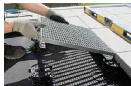
Por supuesto, se pueden combinar fácilmente diferentes tipos de pavimentos como rejillas y placas de hormigón con los soportes elevadores Elefeet®.
