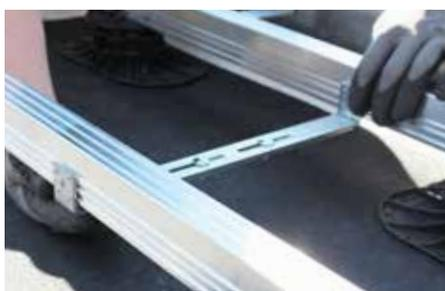
El "espaciador variable" se adapta a cualquier geometría de pavimento deseada y asegura una subestructura segura con dimensiones constantes.
