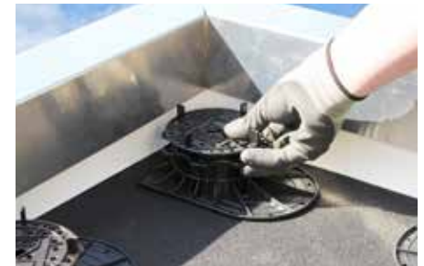
Piezas elevadoras A 12, A 22 y A 67. Se pueden combinar y colocar varias piezas hasta una altura final de aprox. 500 mm
