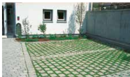
Juntas verdes de una superficie adoquinada
