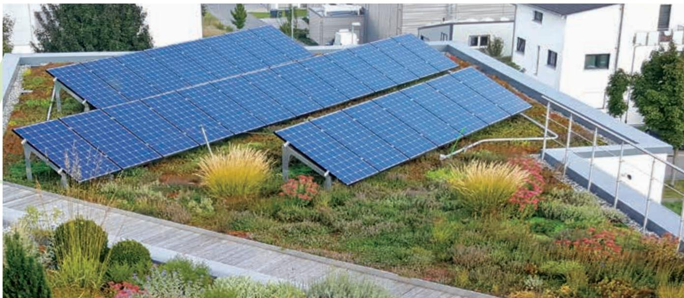
Con el desarrollo de la base solar, ZinCo puede añadir otro beneficio a la lista de ventajas de una cubierta verde – la integración del uso de la energía solar en el sistema de cubierta verde. Con la base solar ZinCo que se integra en el sistema SolarVert®, el rendimiento ecológico de la cubierta verde como área de compensación está totalmente preservada.
