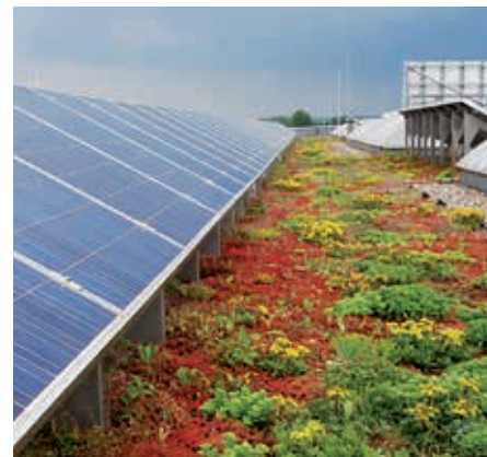
Vista parcial de la cubierta de un centro comercial en Alemania con planta fotovoltaica; tras la instalación del sistema (izquierda) y ya con la vegetación establecida (derecha).
