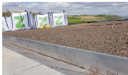
El sustrato Zincoterra Floral fue distribuido en toda la superficie de la cubierta. Para delimitar el sustrato se utilizó el Perfil de separación KL 100/120.
