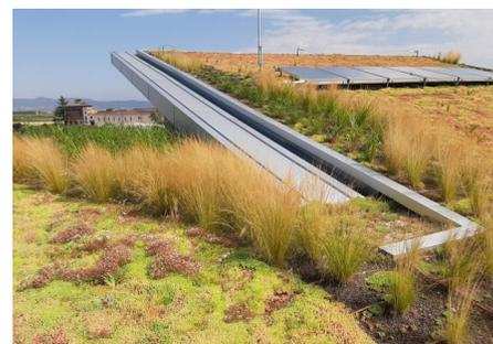
En la pequeña cubierta verde inclinada se utilizó el sistema con la placa drenante Floraset® FS 75.
