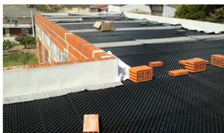
Con el sistema "Sedum tapizante" se colocan los elementos FD 25-E en toda la superficie.
