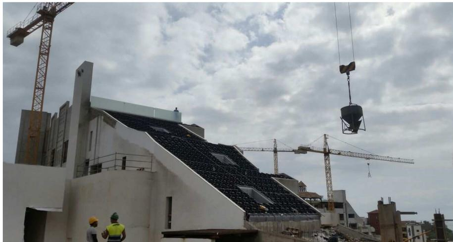
Vista de una de las tres cubiertas después de instalar las barreras de retención y los elementos Georaster.
