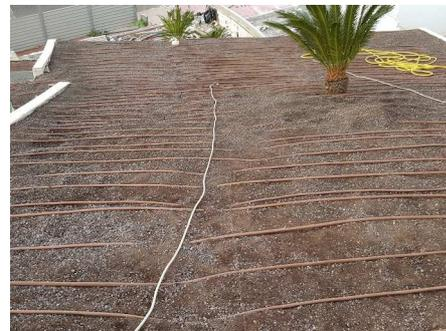
La instalación de dos sistemas de riego coordinados asegura un suministro óptimo de agua.
