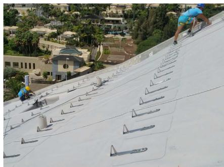
Se instalaron más de 700 soportes antiempuje LF300 como base para las barreras de retención.
