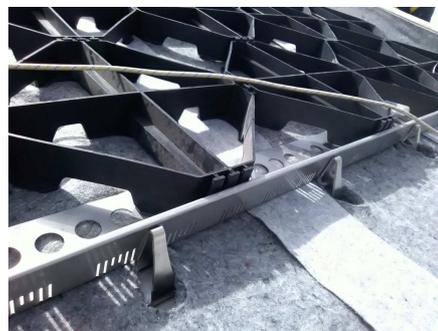
Vista a las barreras de retención con perfil de alero TRP 80, Georaster y manta WSF 150.
