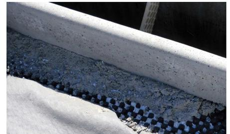
Floradrain® FD 25-E fué usado como molde de soporte y conexión de drenaje en la separación entre superficies duras y ajardinadas.
